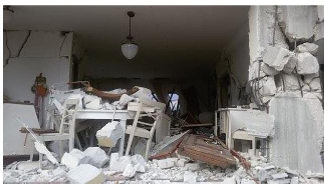
Le strade, quasi tutte sgombre dalle macerie, ti guidavano in un percorso di distruzione totale. Nelle strutture delle poche case non crollate, si vedevano i segni dell'azione del sisma. Gli effetti di risonanza sulle strutture che hanno letteralmente spaccato in due i pilastri e sbriciolato il calcestruzzo per rottura, con i ferri di armatura deformati ed esposti.
